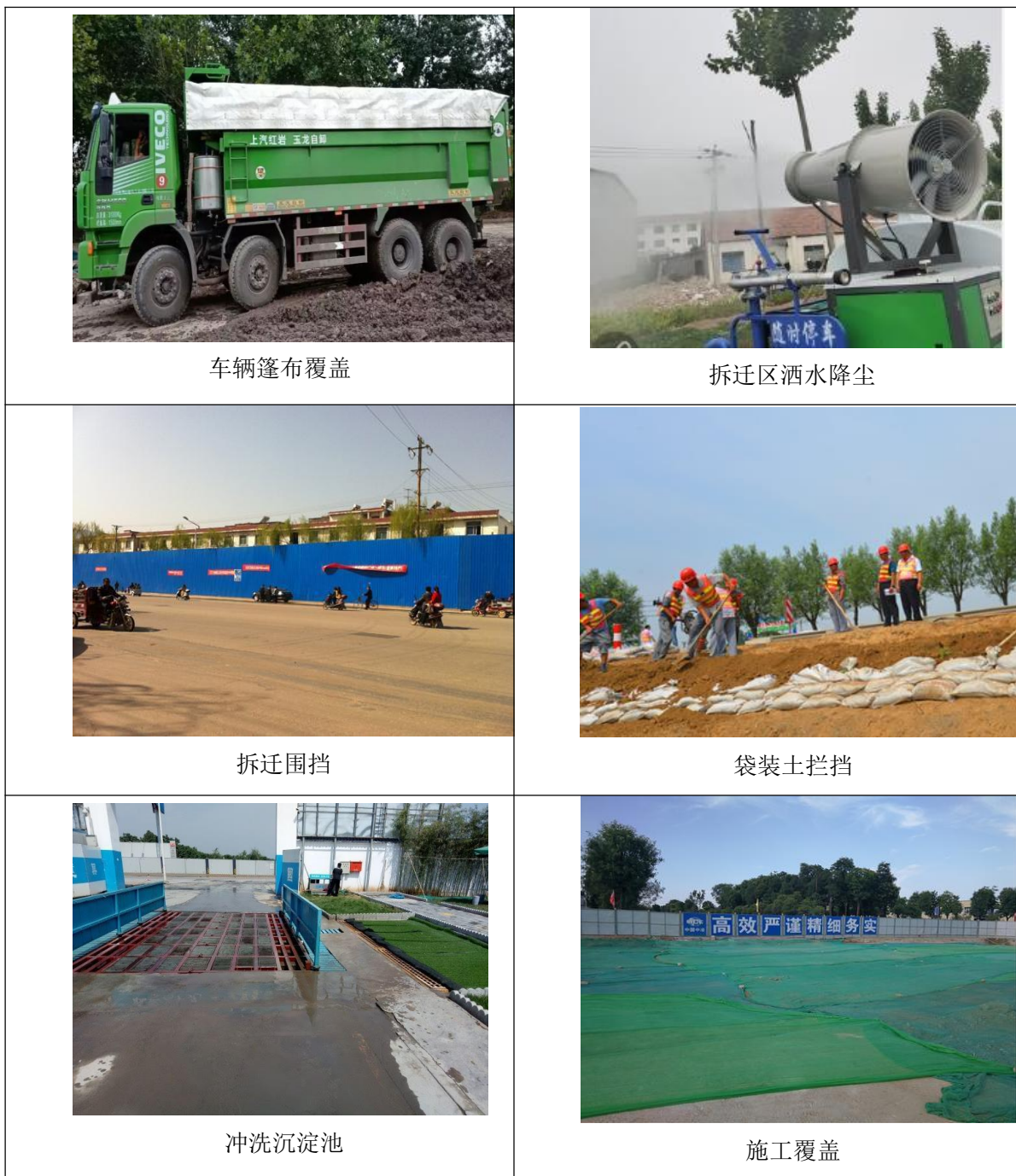
图 5.1-1 施工期环保措施图片
