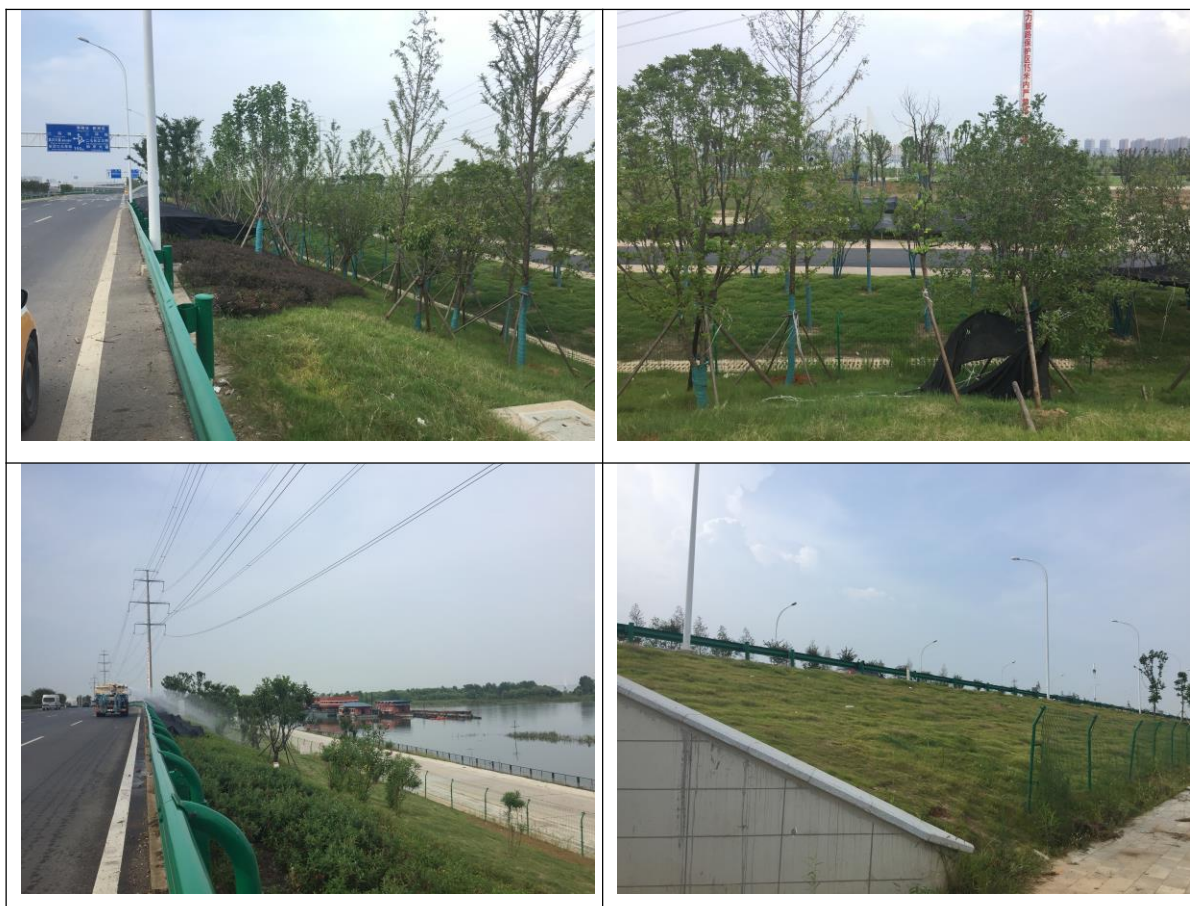
图 6.1-2 边坡防护及绿化情况
