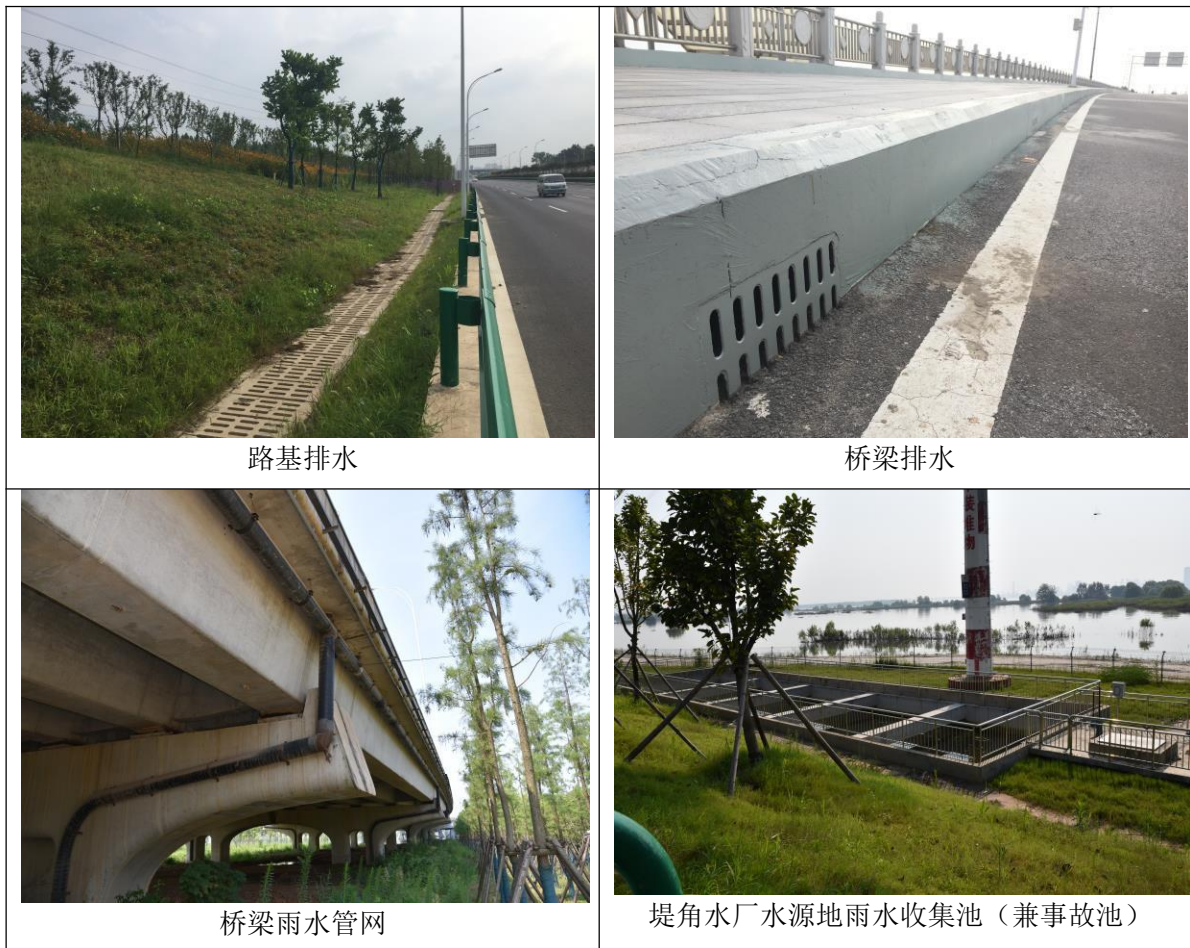
图 6.1-5 路面及桥梁排水系统设置情况
