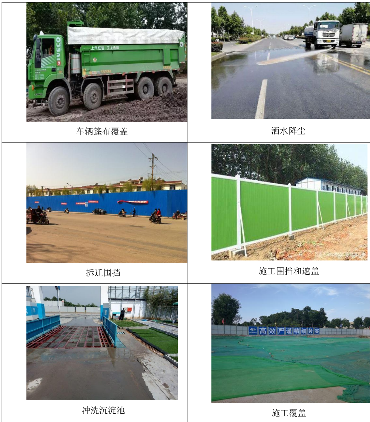
图 6.4-1 施工期现场抑尘照片
